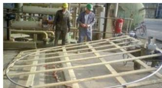
Große Flansche ( $\geq$  DN600) bergen zusätzliche Herausforderungen, da entsprechende Dichtungen üblicherweise abseits des Einsatzorts angefertigt werden müssen. Lange
