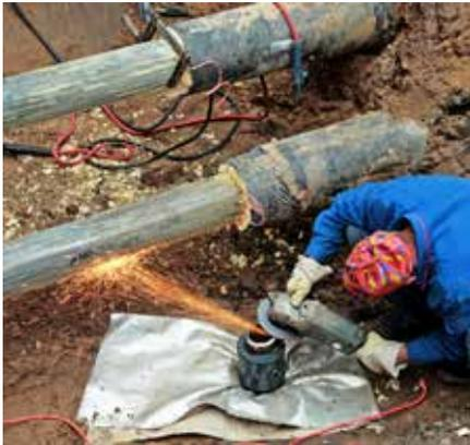
Die Fernwärme- / Kälteleitung befindet sich im Betriebszustand. Weder Temperatur, noch der Druck müssen abgesenkt werden, um eine Netzerweiterung nach den geltenden Sicherheitsbestimmungen durchzuführen.
