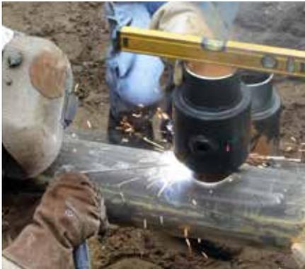
Der JIP® Anbohrhahn wird an den Rohrleitungsdurchmesser angepasst.
