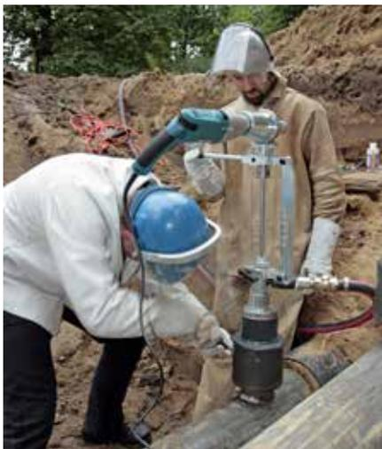
Nach erfolgter Anbohrung wird das Werkzeug zurückgeführt und der JIP® Kugelhahn geschlossen.
