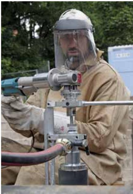
Das hier gezeigte Winkelgetriebe ist für die Nennweiten DN 65 bis DN 100 zwingend erforderlich.
